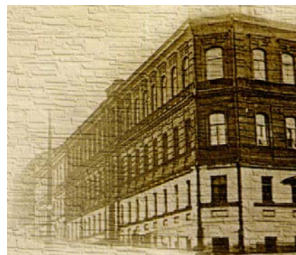
Здание по Гоголевской улице, в котором с 1910 по 1921 г. размещался Витебский учительский институт
